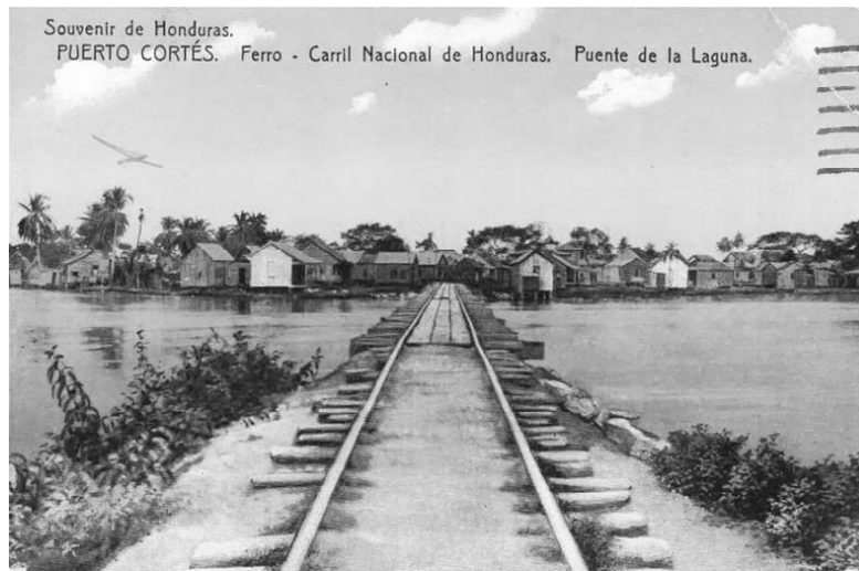
Tarjeta postal, Puente La Laguna, ingreso a Puerto Cortés
